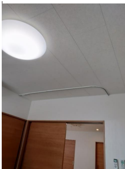
改修工事施工後②▼ 天井の改修工事
