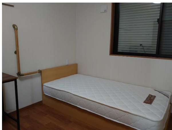
改修工事施工後③▼ 壁の改修工事 手すりの設置
