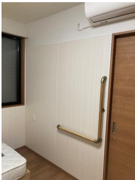
改修工事施工後①▼ 壁の改修工事 手すりの設置
